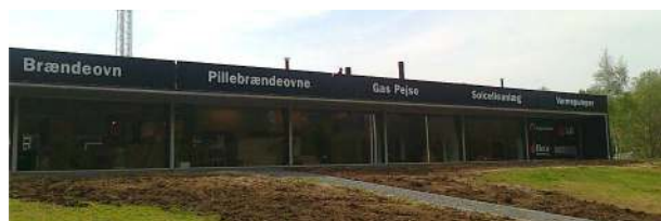
40 meter butiksfacade monteret med alubakker og FACADEbogstaver indbygget LED.
