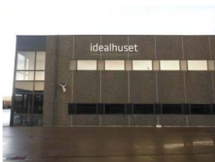
PVC bogstaver monteret med gevindstag.
